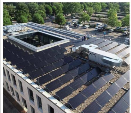
Nachhaltig: Das neue Rathaus in Offenbach an der Queich wurde mit Photovoltaikmodulen und PVT-Modulen (zur Strom- und Wärmeenergiegewinnung) ausgestattet. Foto: Axel Wassyl
