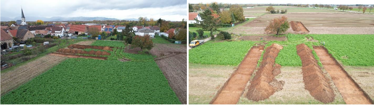
Abbildung 8: Übersichtsaufnahmen der Sondagearbeiten (Quelle: GDKE 2023)
