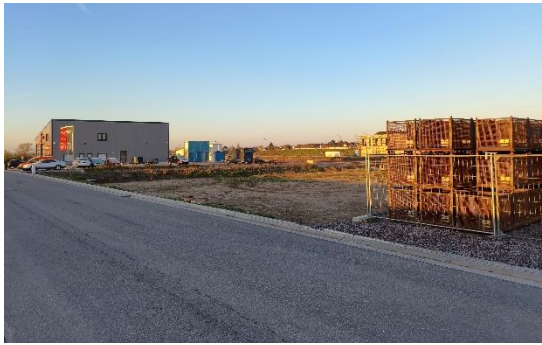
Blick von Nord-Ost in den Geltungsbereich
