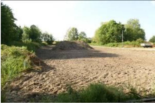
Foto 7: Nunmehr gänzlich abgeschobener Oberboden in W 6 (28.8.2018)
