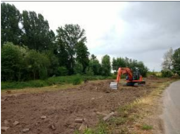
Foto 5: Baggerarbeiten im östlichen Teil von W 6 am
