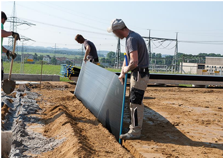
Abbildung 14: Beispiel für Erdwärmekollektoren
